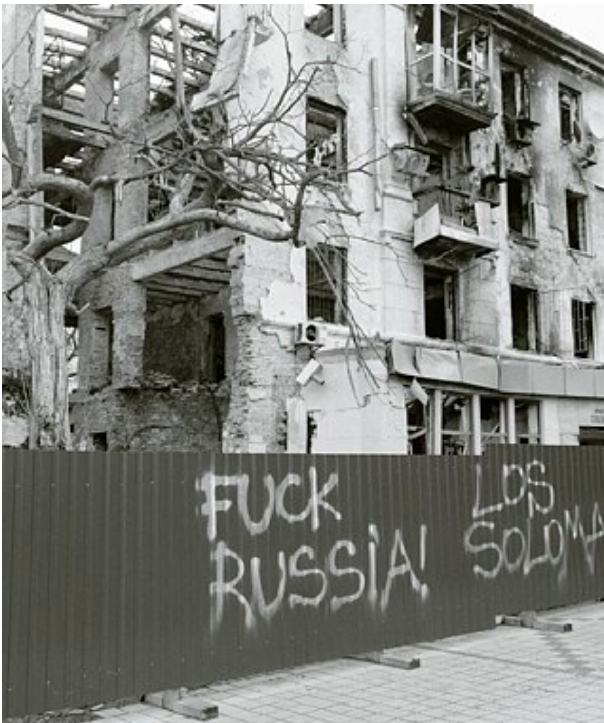
Zerstörtes Wohnhaus in Kramatorsk | Foto: © Sitara Celina Rajh
